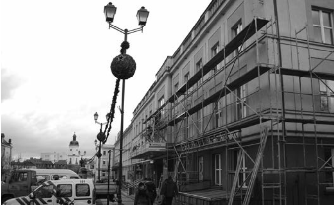
Budynek w trakcie remontu.
