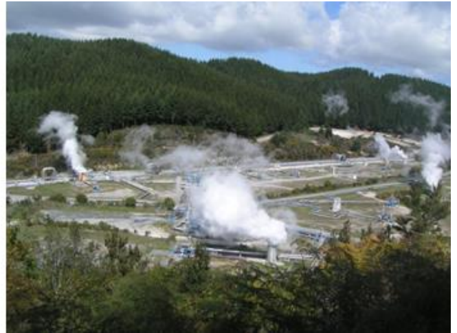
Elektrownia geotermalna Wairakei.
