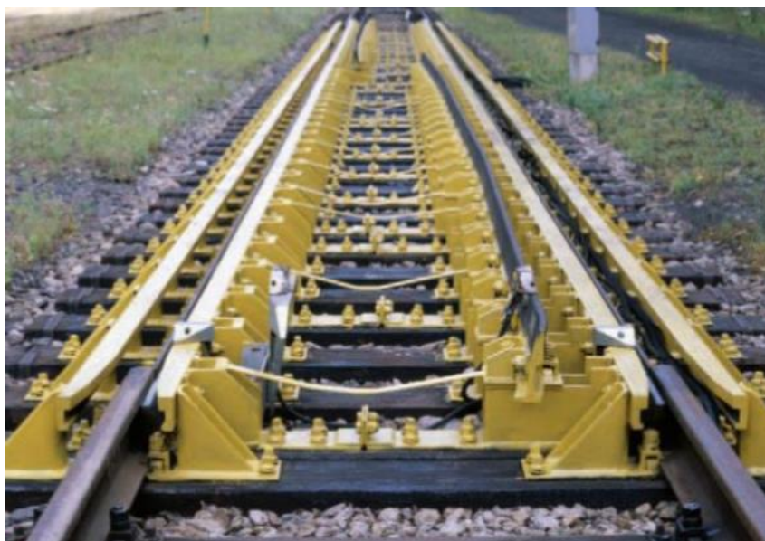
Rys. 5. Torowe stanowisko przestawcze systemu SUW 2000 [24].
